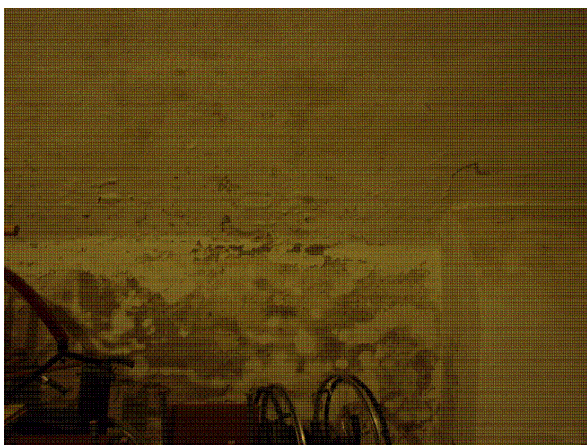
7. Zniszczenia tynków
