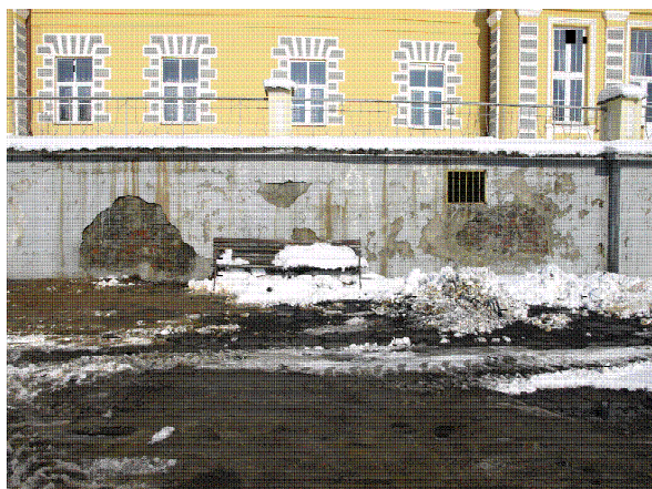
11. Zniszczenia tynków zewnętrznych
