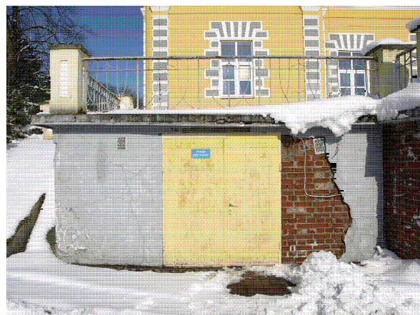
10. Zniszczenia tynków zewnętrznych
