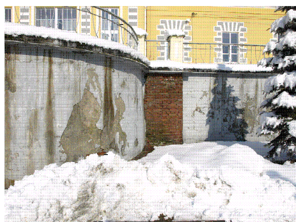
12. Zniszczenia tynków zewnętrznych
