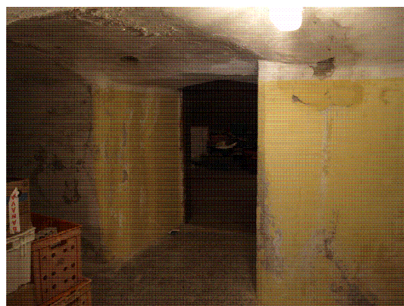
8. Zniszczenia tynków z wykwitami soli
